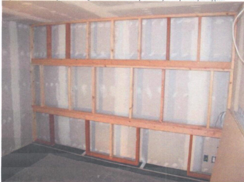
Rysunek 2: Szkielet ściany akustycznej (przykład)
