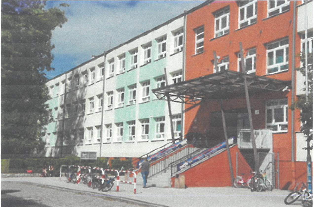
Wejście do budynku
