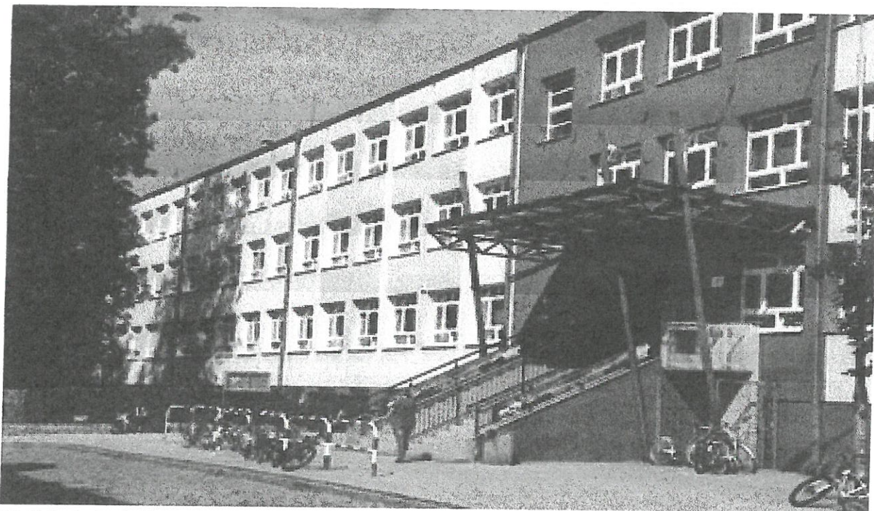
Wejście do budynku
